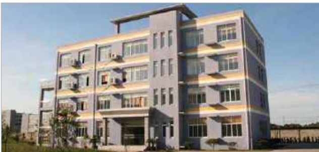
Soudal PU foam production: Shanghai, China
